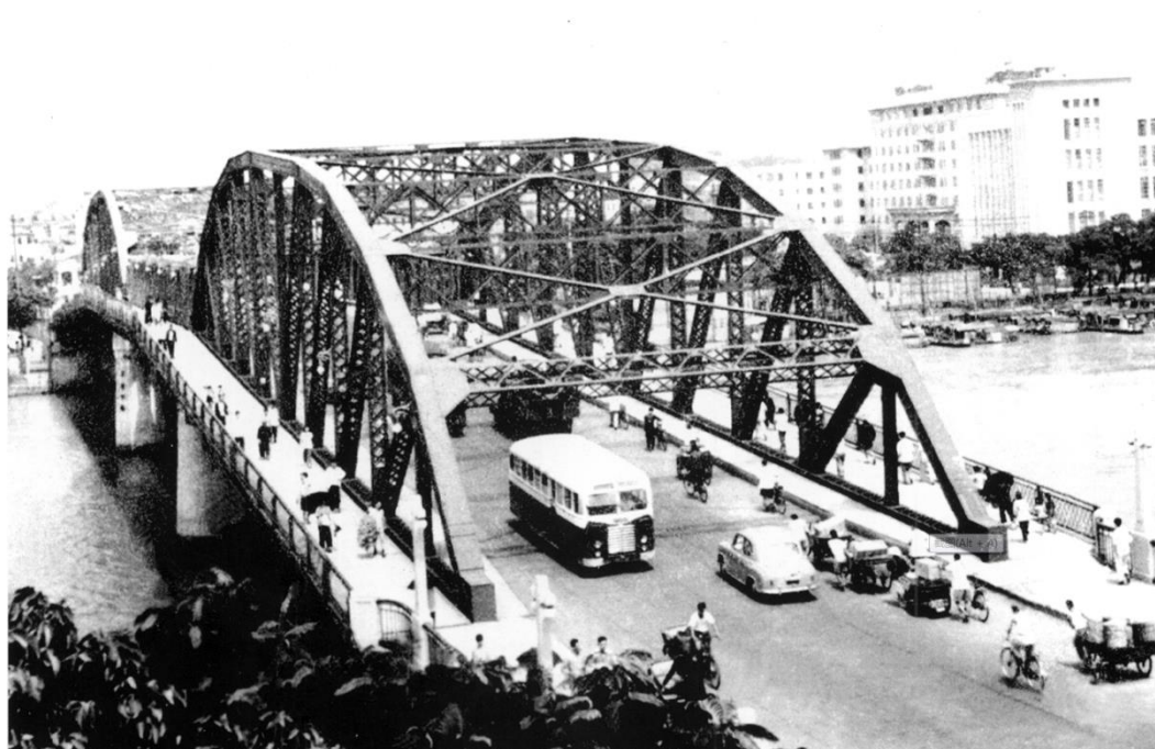
修复后的海珠桥
